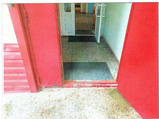
Фото № 9 – Внешняя входная дверь
