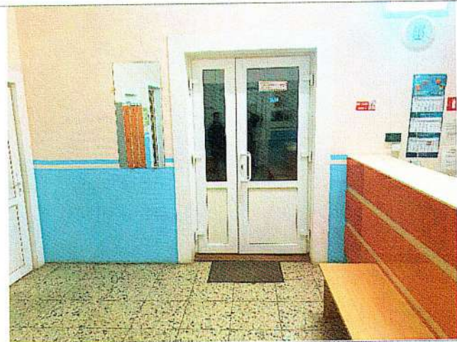
Фото № 15 – Пути движения внутри здания (двери).
