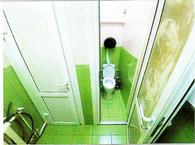
Фото № 28 – Санитарно-гигиеническое помещение
