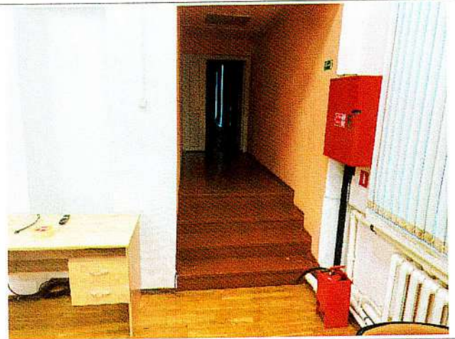
Фото № 18 - Пути движения внутри здания (лестница).
