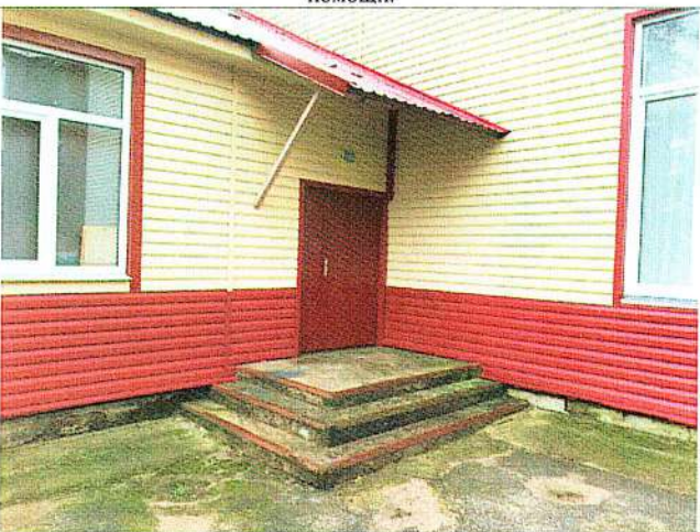
Фото № 35 – Запасной выход
