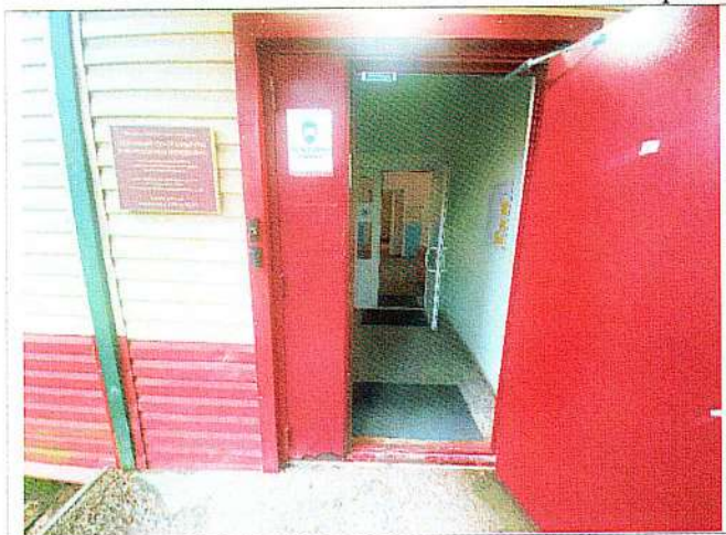
Фото № 7 – Входная площадка
