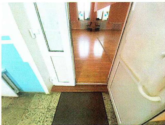
Фото № 23 – Пути движения внутри здания (двери).
