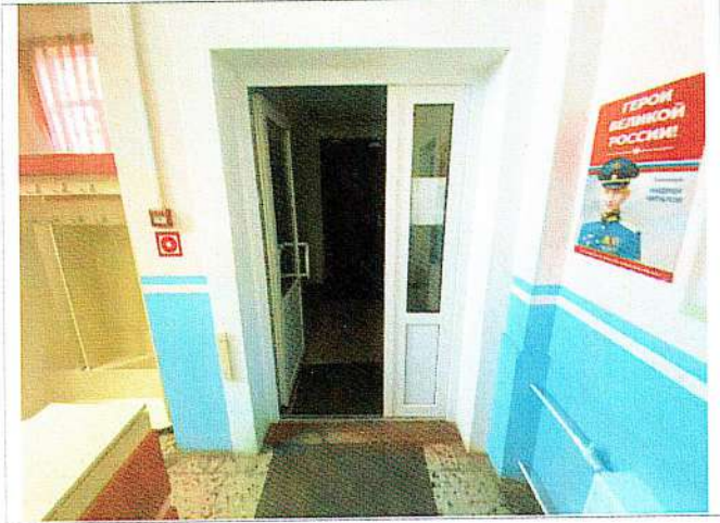
Фото № 13 – Внутренняя входная дверь
