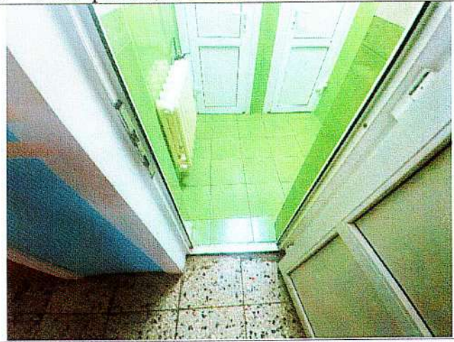
Фото № 26 – Санитарно-гигиеническое помещение
