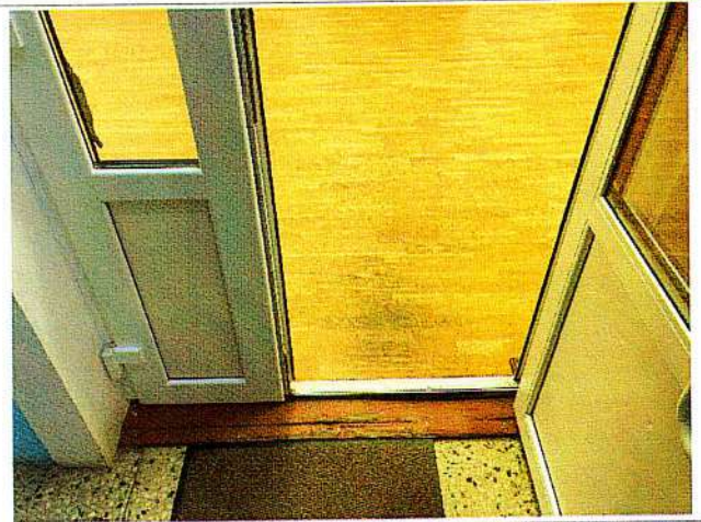
Фото № 16 – Пути движения внутри здания (двери).
