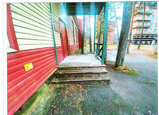
Фото № 6 – Наружная лестница, кнопка вызова персонала, для оказания необходимой помощи. Входная площадка.
